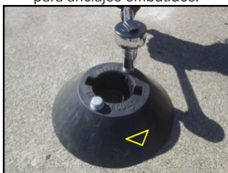
Asegure la base al hormigón o al asfalto con una llave de tubo y tornillos.
