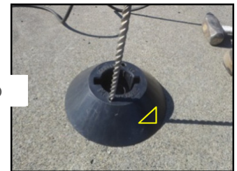
Utilice una estaca o un taladro de carburo de 1/4" para marcar las ubicaciones de los agujeros con las flechas orientadas en dirección al tráfico. Consulte los estándares sobre protección respiratoria de la OSHA para conocer sobre la exposición a la sílice cristalina.
