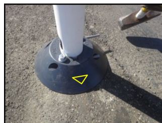
Coloque el poste en la base e introduzca los pernos en su lugar para asegurarlo.
