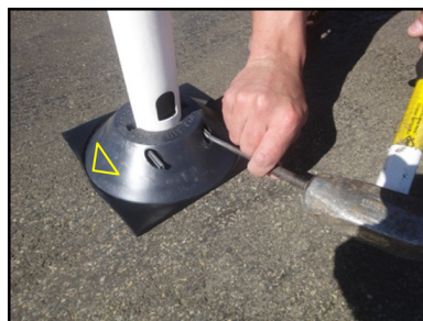
Termine de introducir los pernos con un punzón.
