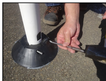
Utilice una herramienta punzonadora para instalar los pernos dentro de la base
