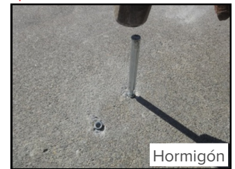
Coloque los anclajes embutidos con una herramienta adecuada para su colocación.
