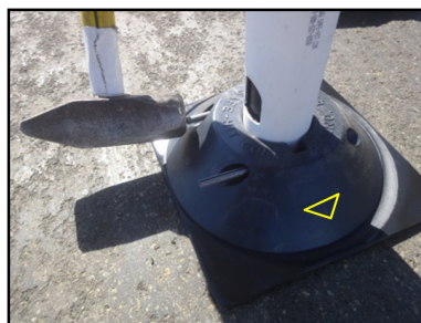
Coloque el poste en la base e introduzca los pernos en su lugar para asegurarlo.
