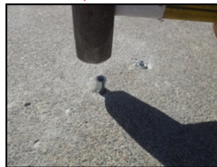
Coloque los anclajes en los agujeros y golpéelos con un martillo.
