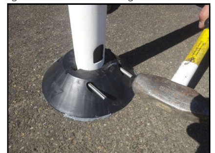
Deje que el epoxi se fije, luego coloque el poste dentro de la base y golpee los pernos hasta que queden alineados con la base (ver nota).
