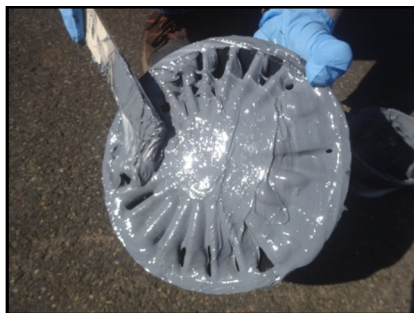
Aplique epoxi de manera uniforme en la parte posterior de la base con una vara para remover.
