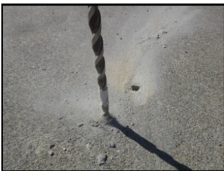
Taladre 5/8" (15,88 mm) X 2 1/2" (63,5 mm) de profundidad para anclajes tipo escudo de retraso (asfalto) o 1/2" (12,7 mm) X 1 5/8" (41,28 mm) de profundidad para anclajes embutidos.
