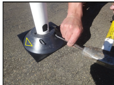
Termine de introducir los pernos con un punzón.
