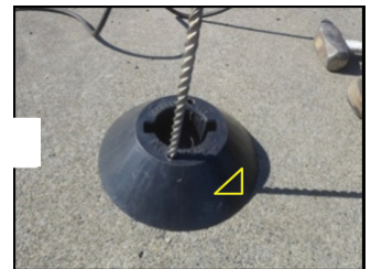
Utilice una estaca o un taladro de carburo de 1/4" para marcar las ubicaciones de los agujeros con las flechas orientadas en dirección al tráfico. Consulte los estándares sobre protección respiratoria de la OSHA para conocer sobre la exposición a la sílice cristalina.
