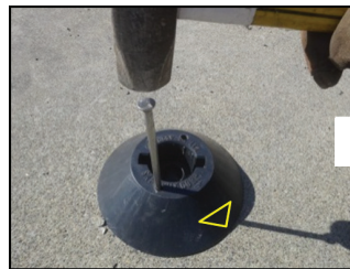
Utilice una estaca o un taladro de carburo de 1/4" para marcar las ubicaciones de los agujeros con las flechas orientadas en dirección al tráfico. Consulte los estándares sobre protección respiratoria de la OSHA para conocer sobre la exposición a la sílice cristalina.
