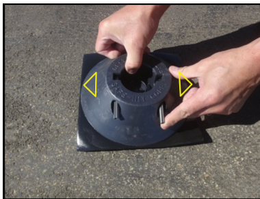
Coloque la parte recientemente descubierta con las flechas orientadas hacia la dirección del tráfico.
