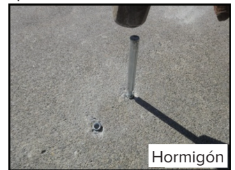
Coloque los anclajes embutidos con una herramienta adecuada para su colocación.
